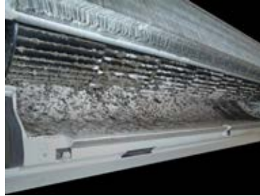
El moho prospera en las ruedas de soplador mini-split
